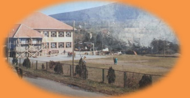
Радови на реконструкцији и доградњи школе 1994. год.
